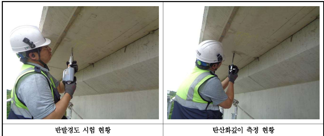
【사진 30.4.1】 콘크리트 내구성조사 현황
