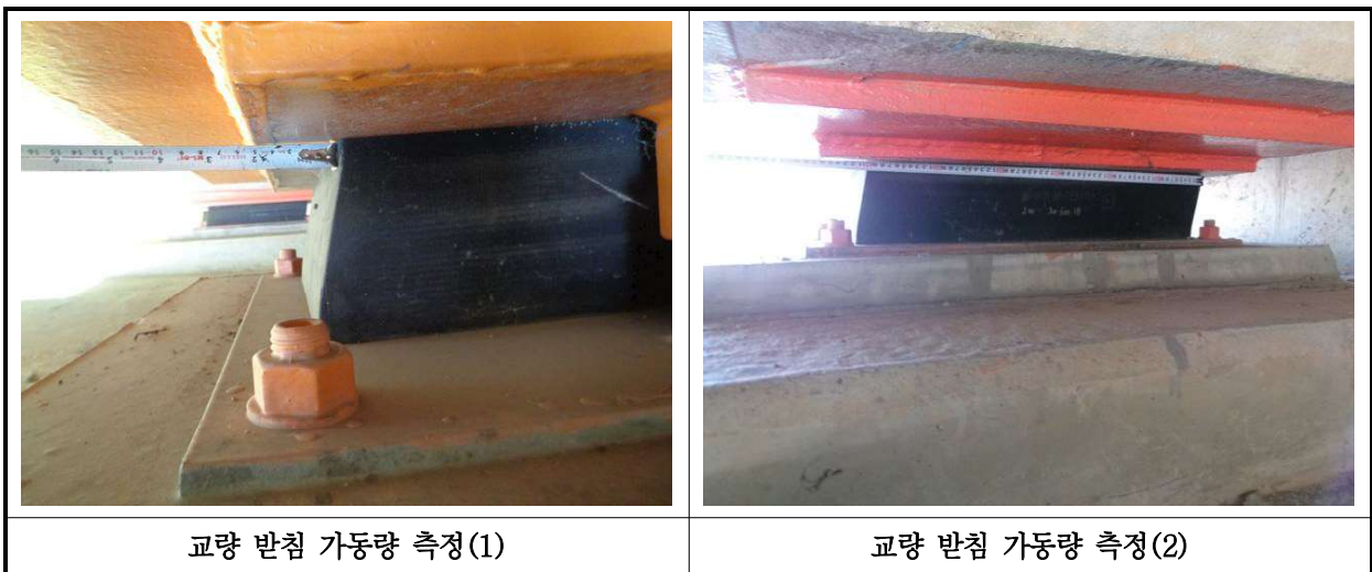
【사진 30.3.15】 교량받침 이동량 측정
