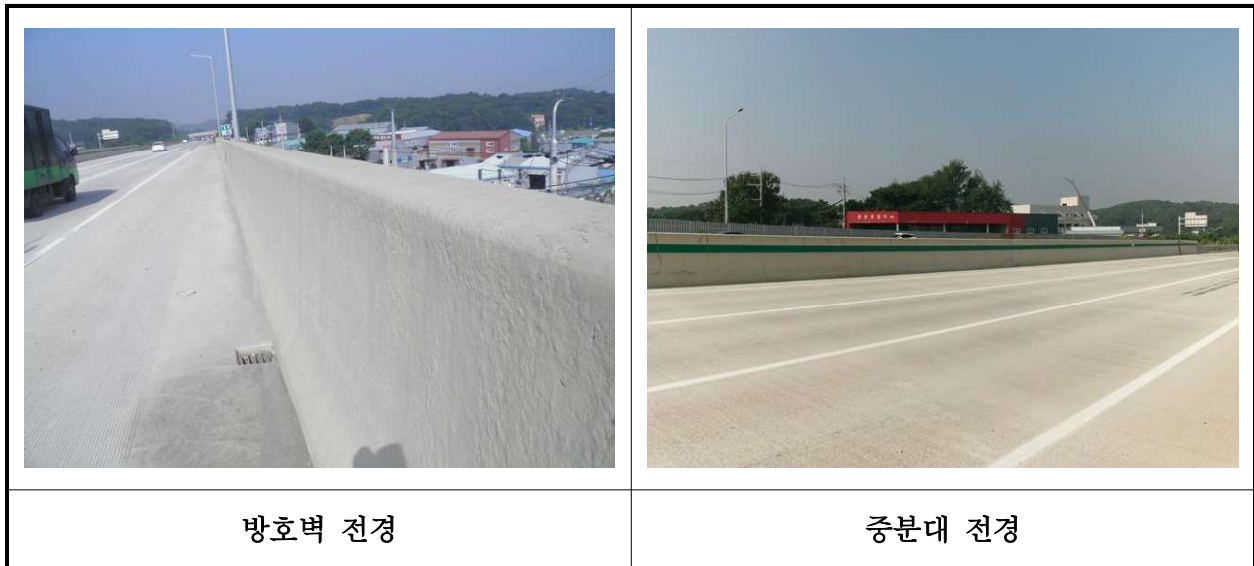
【사진 30.3.23】 방호벽 및 중앙분리대 전경
