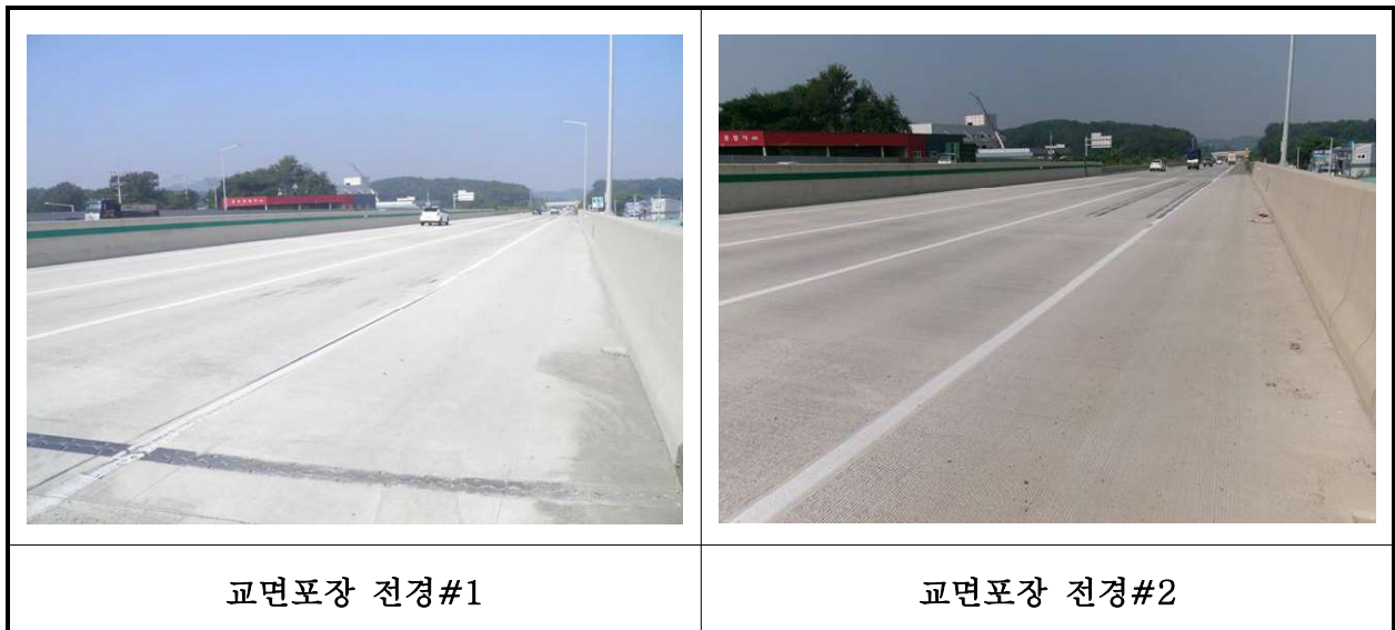
【사진 30.3.19】 교면포장 전경
