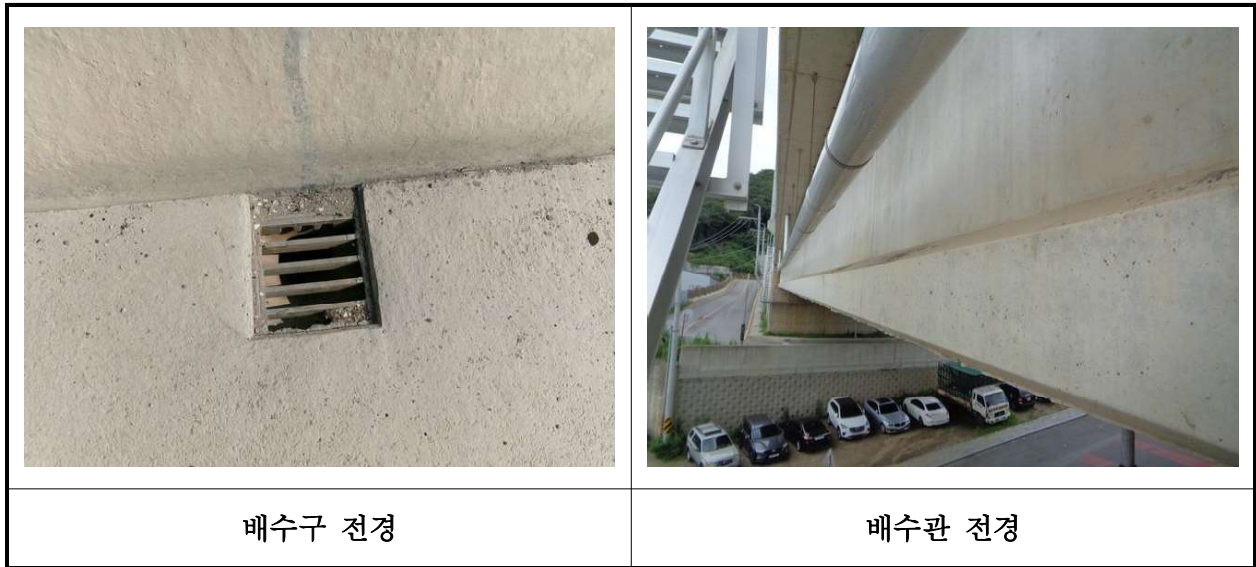
【사진 30.3.21】 배수시설 전경
