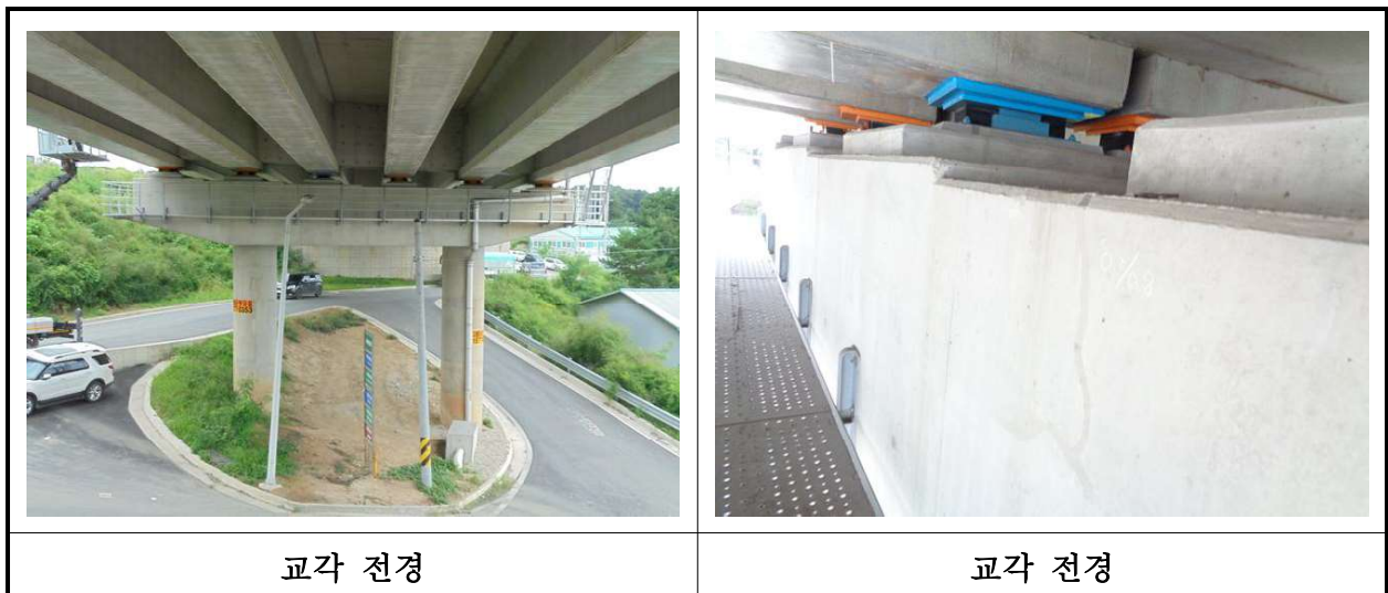
【사진 30.3.10】 교각 전경
