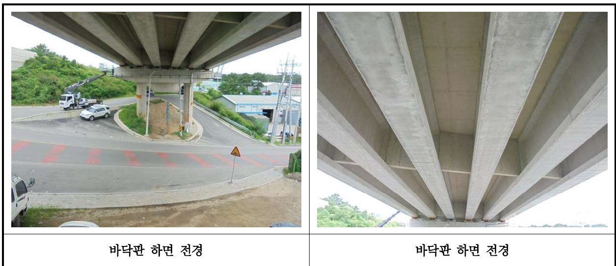
【사진 30.3.2】 바닥판하면 전경
