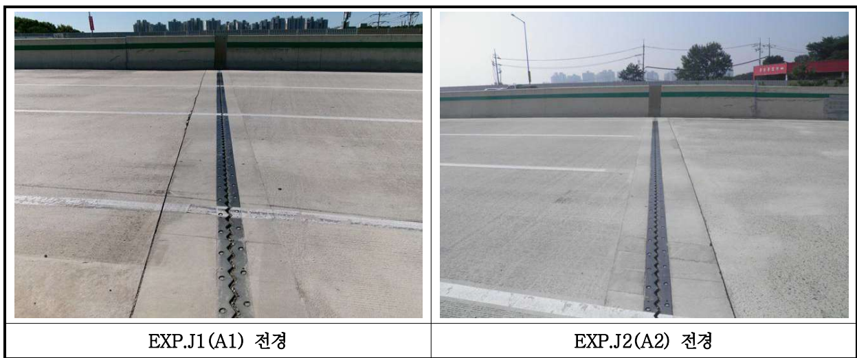
【사진 30.3.16】 신축이음장치 전경
