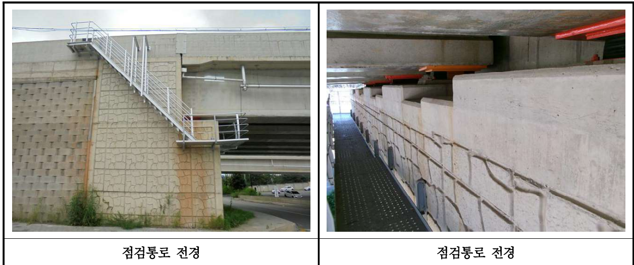
【사진 30.3.25】 교량 점검시설 전경
