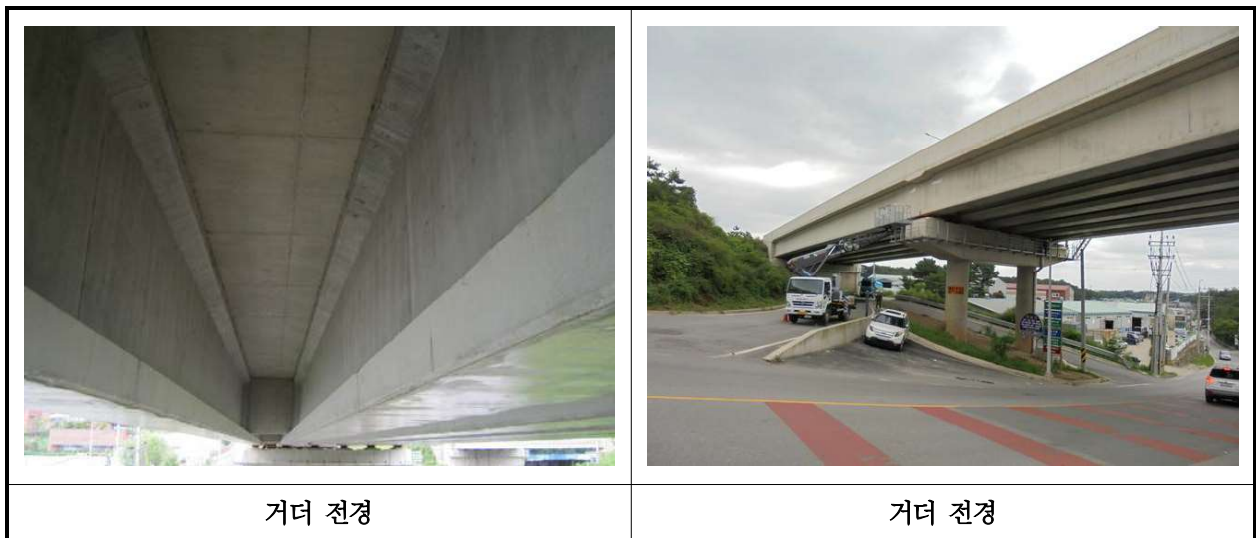
【사진 30.3.4】 거더 전경
