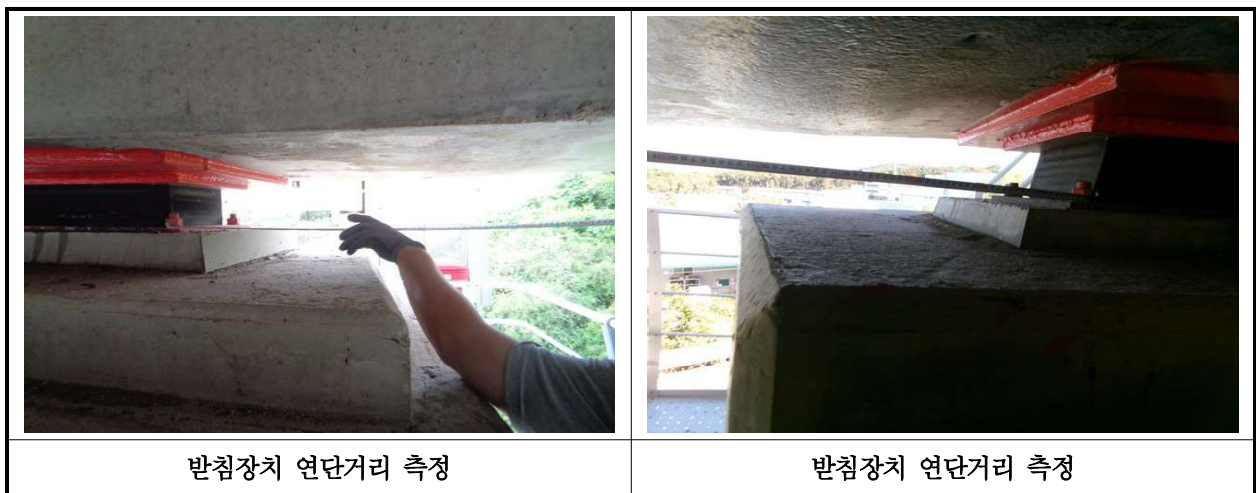
【사진 30.3.14】 교량받침장치 연단거리측정
