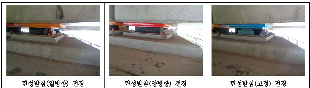
【사진 30.3.12】 교량받침 전경
